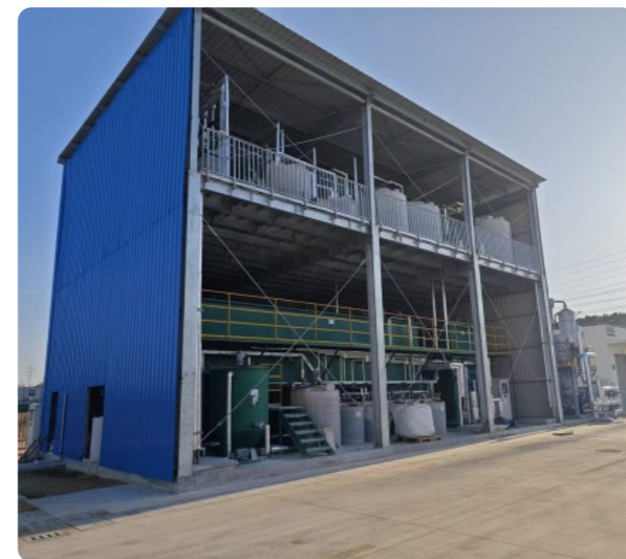
森松苏州工厂污水处理设施图片
